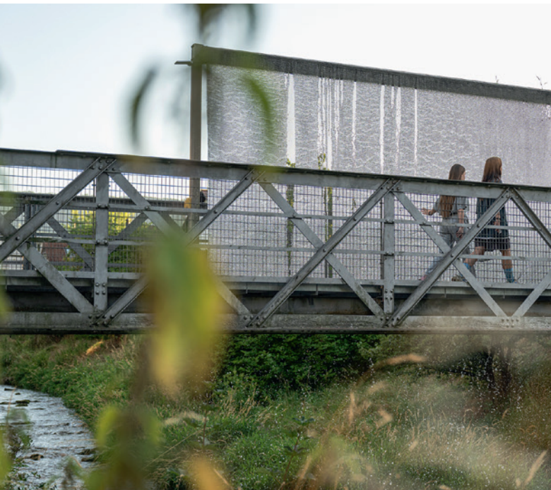
↑ Ein Wasserschleier auf der Vorstadtbrücke über die Reppisch
